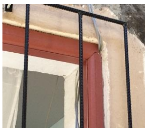
Instalación cableados temporales
