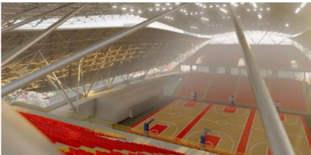
Vista interior canchas para entrenamiento
