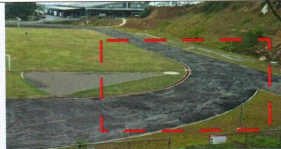
**Fotografía 2.** Vista del acabado desigual de la carpeta asfáltica.
