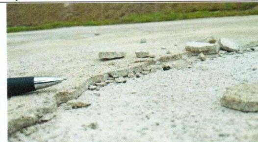
**Fotografía 5.** Detalle de desprendimiento de mortero en losa de salto con pértiga.
