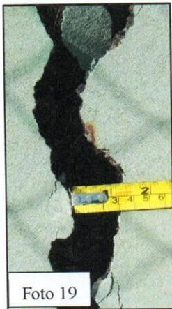
La grieta se ubica en el sector oeste de la cancha de tenis. En uno de sus puntos, se detectó un ancho de hasta 3cm y una profundidad de hasta 19 cm de ancho
